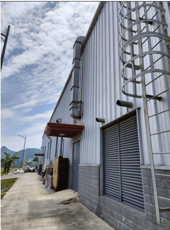
应急发电机房及排气筒
